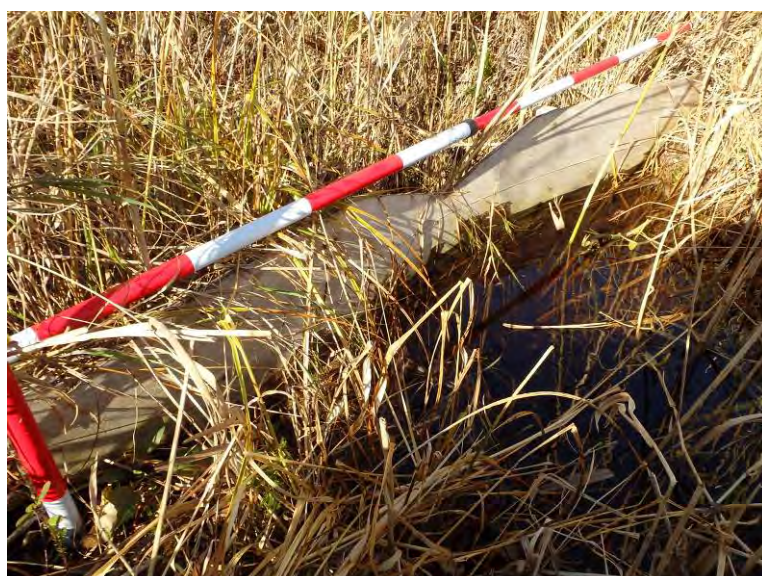
写真 6-3 水抜き水路 3 仮堰
