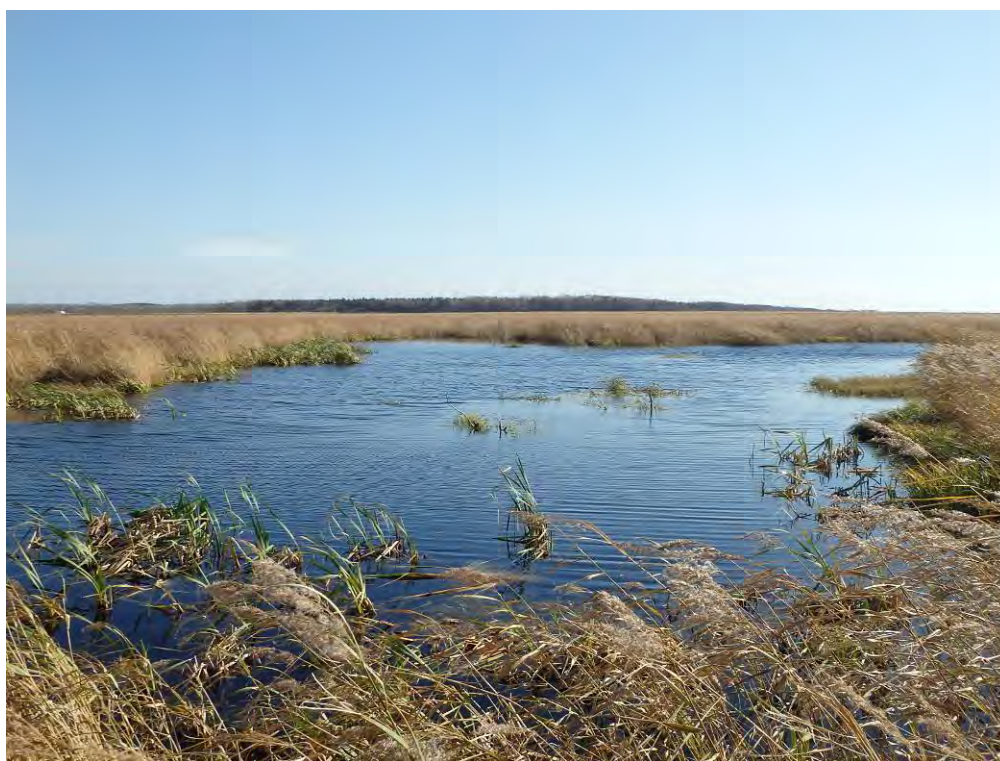
落合沼堰き止め工の施工後5年目となる平成27年10月の状況。落合沼に湛水面が維持されている。
