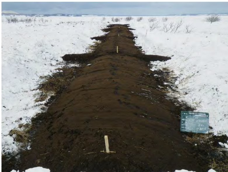
水抜き水路 4 施工直後 平成 26 年 2 月 15 日撮影
