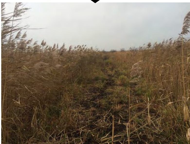
水抜き水路 4 施工直後 平成 26 年 10 月 20 日撮影
