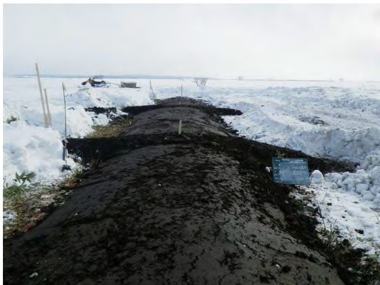
水抜き水路 5 施工直後 平成 26 年 2 月 13 日撮影
