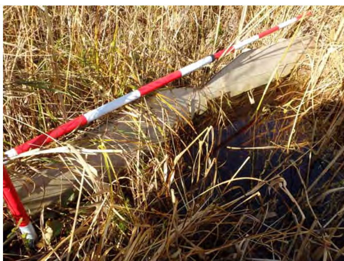
写真 3-1 水抜き水路 3 における仮堰上げの状況
