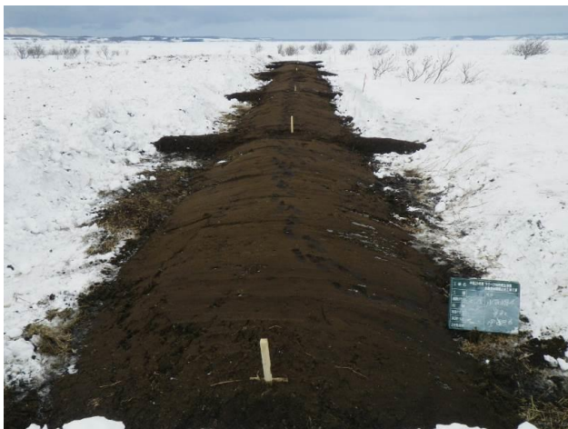
水抜き水路 4 施工直後 平成 26 (2014) 年 2 月 15 日撮影
