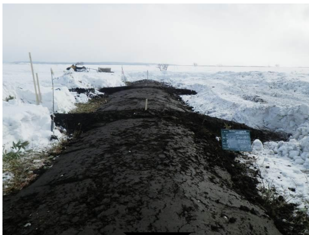
水抜き水路 5 施工直後 平成 26 (2014) 年 2 月 13 日撮影
