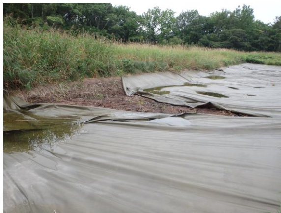
写真 6-9 泥炭ストックヤードのシート
