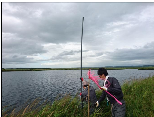
写真 2-1 観測孔の新規設置状況
