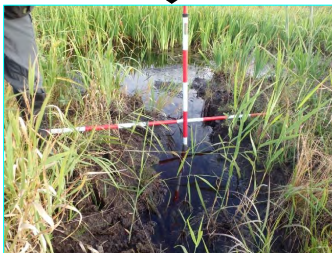
図 6-7 旧河川跡堰き止め工 越流部の状況
