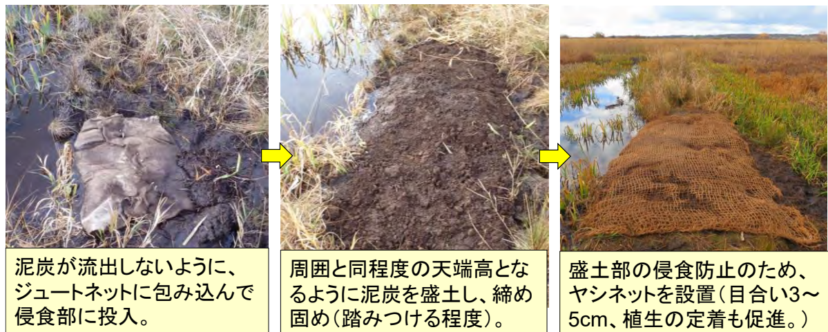
図 6-8 旧河川跡堰き止め工 越流部の補修状況
