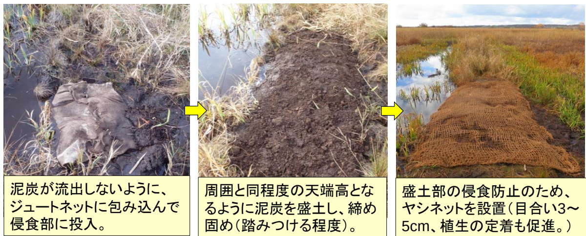
図 5-8 旧河川跡堰き止め工 越流部の補修状況
