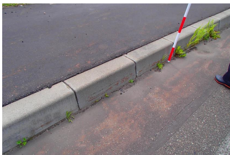
図 4-14 工事用進入路の歩車境界ブロック(撤去・再設置)
