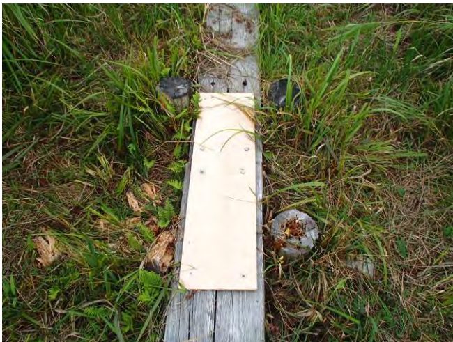
ベニヤ板による補修
