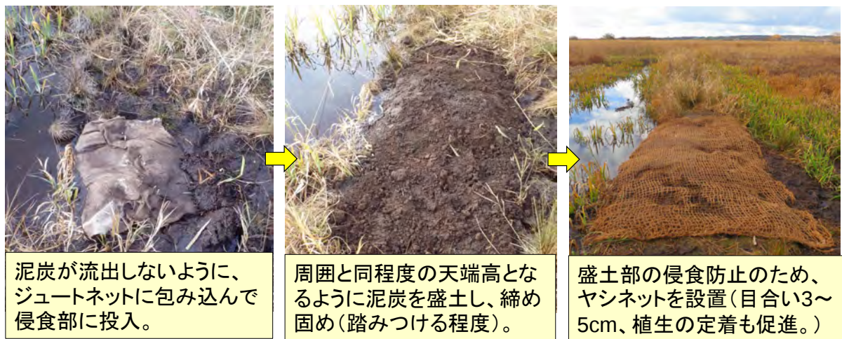
図 4-13 旧河川跡堰き止め工 越流部の補修状況
