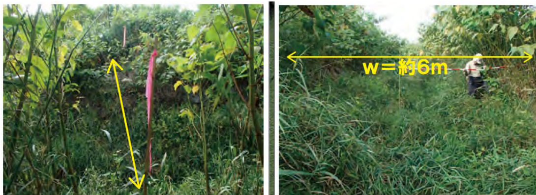
排水路を渡る部分の現況写真
