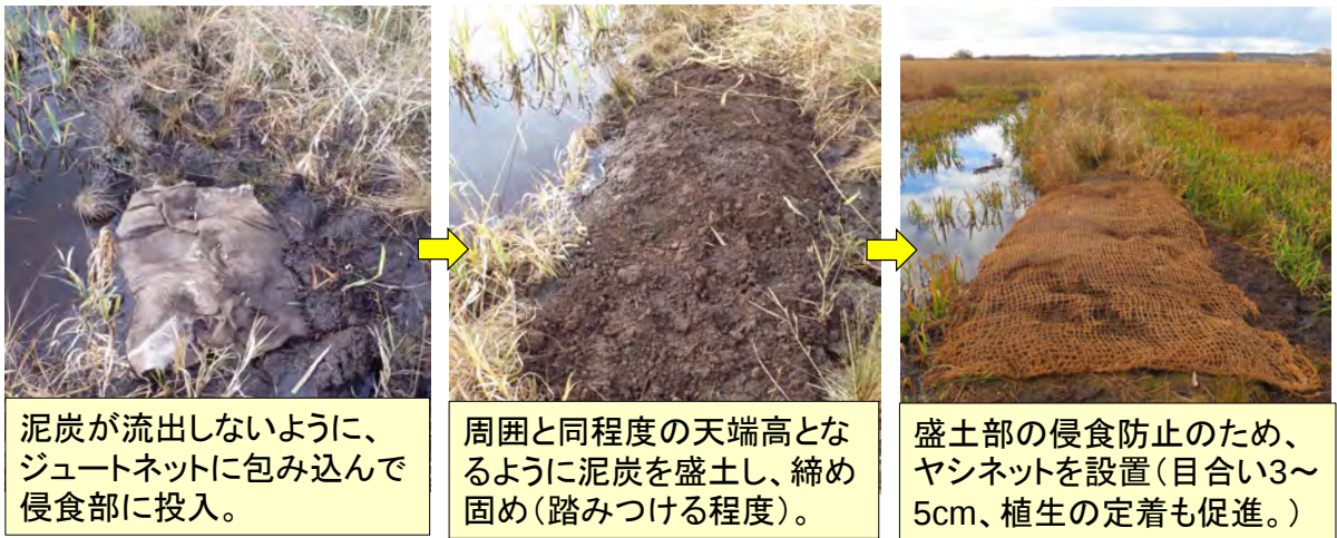
図 4-9 旧河川跡堰き止め工 越流部の補修状況
