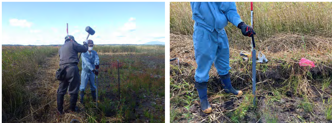
図 2-1 地下水観測孔設置状況
