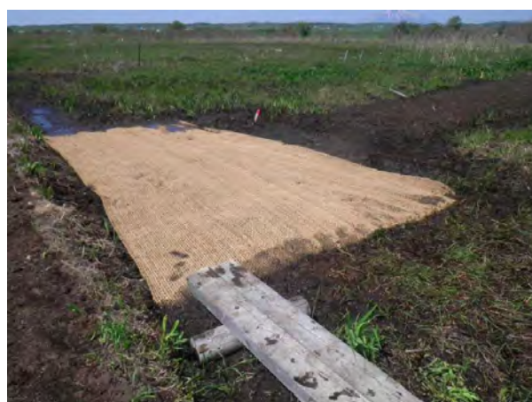
平成 28 (2016) 年 5 月撮影 (施工直後)
