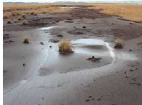
図 5-19 降雨後にみられた水の流れた跡
