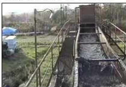
浚渫船からポンプで圧送された泥炭採掘水。 植物繊維を多く含む。
