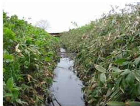
図 4-6 側溝(サロベツ川合流付近)
