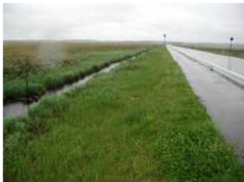
図 4-5 丸山道路と側溝
