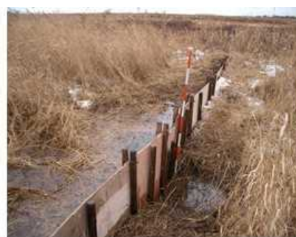
落合沼流出部 堰上げ直後の状況 (堰の延長は105m、水路底から約1.1m堰上げ)
