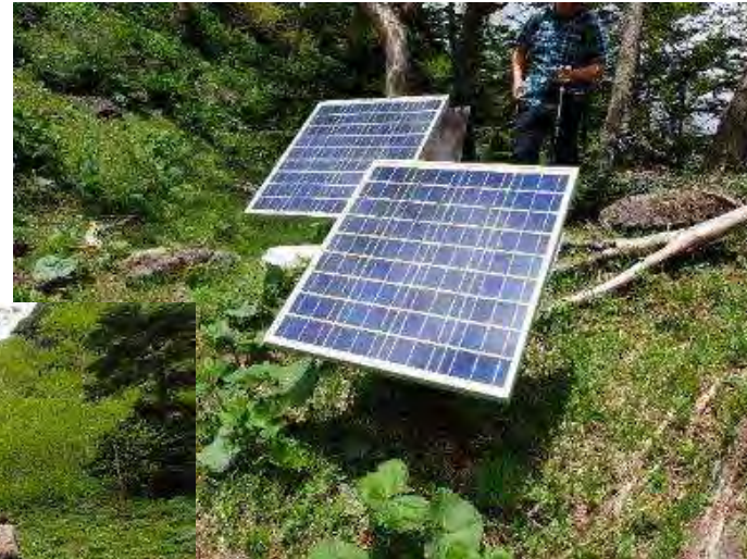
電気柵はソーラーパネルと 充電バッテリーで駆動
