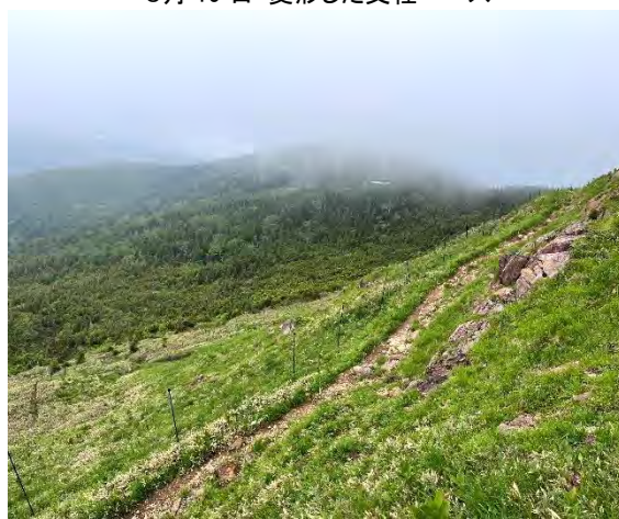
7月2日 植生保護柵設置完了
