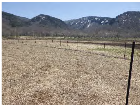
5月16日 支柱の設置
