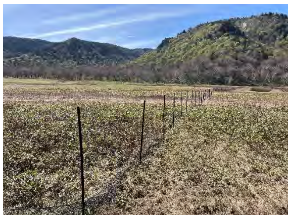
5月15日 支柱の設置
