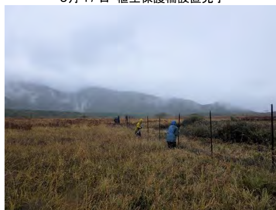
10月8日 支柱の撤去
