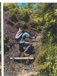
分岐点手前 杭打ち込み
