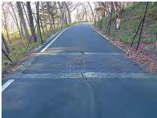
写真Ⅲ 2－4 道に設置されたグレーチング
