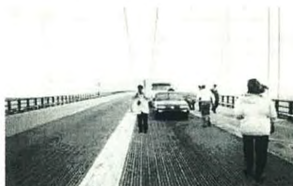
写真Ⅲ 2－9 1957年に完成したマキナック橋（アメリカ）は4車線のうち、2車線がオープングレーチングになっている。（広沢 et al. 2003）
