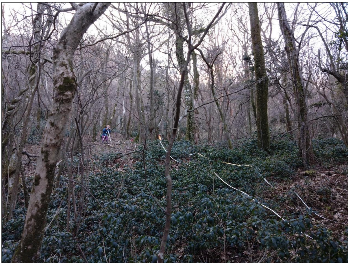
写真2-2-1 測量作業の様子
