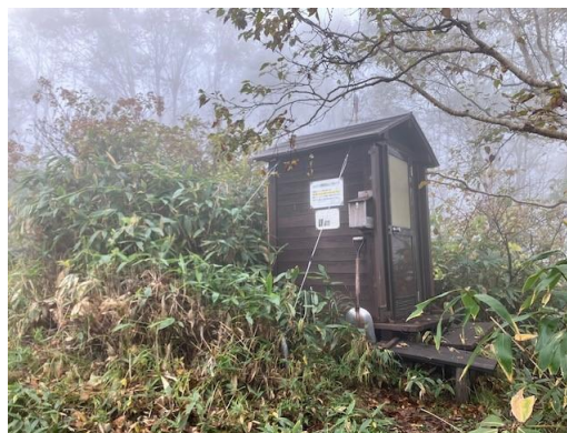
携帯トイレブース
