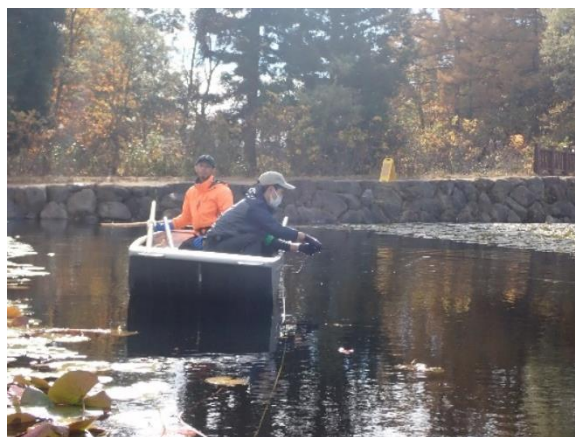
シートの重しとなっている土嚢袋(砂詰)を 一時的に撤去
