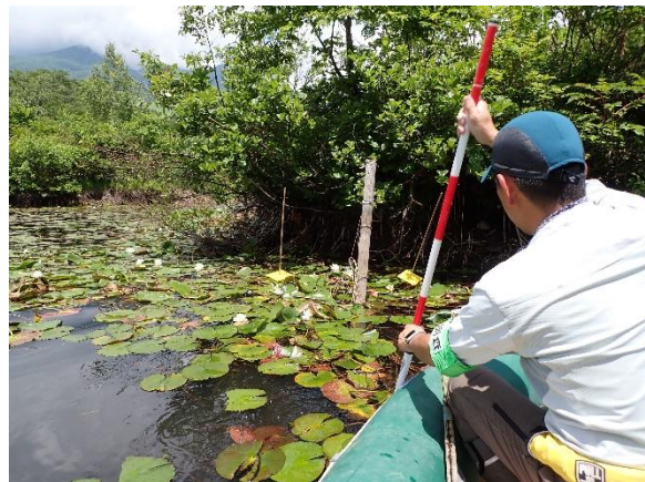
測量ポールでシート設置位置を確認
