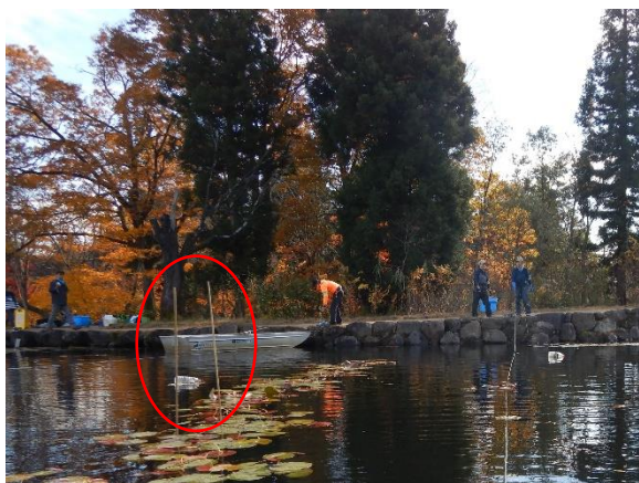
敷設範囲の目印として シートを剥がす前に竹杭を設置
