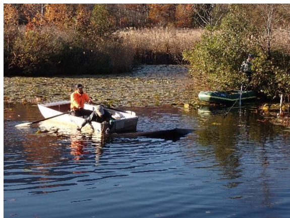
採取後、ボートと陸地(島)からロープを引いて 剥がしたシートを元の設置状況に戻した
