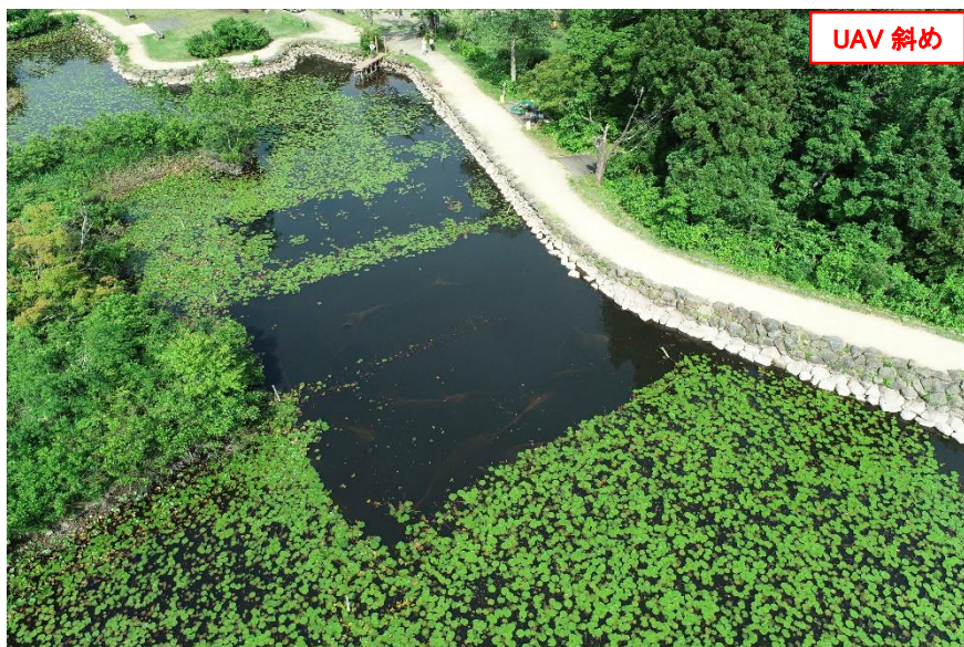
写真 2-6 メンテナンス後のR1試験範囲のUAV空中写真(R4.6.28撮影) 上:遠景、中:近景、下:斜め
