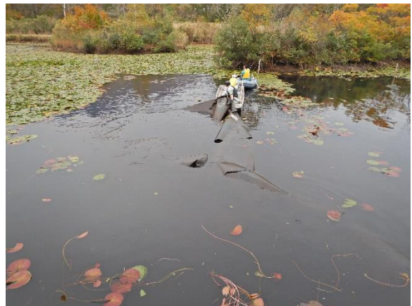
剥がしたシートはロープで縛り対岸の杭に固定した
