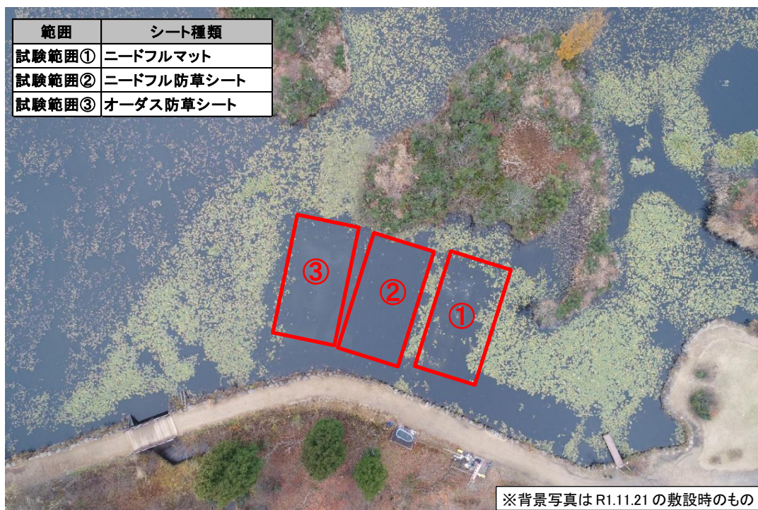
図 2-1 令和元年度に敷設した遮光シートの配置
