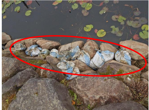
一時的に撤去した土嚢袋
