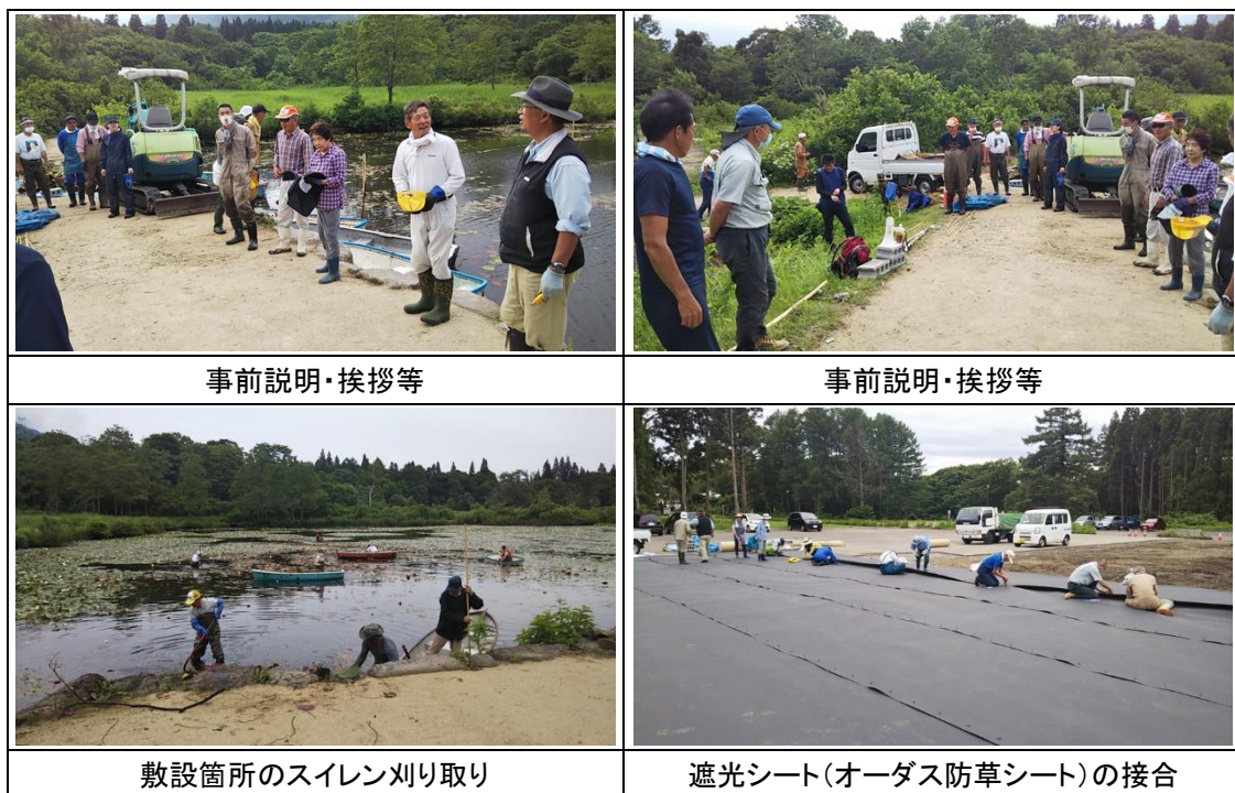
写真 3-1 現地での設置指導及び設置作業の様子 1/2
