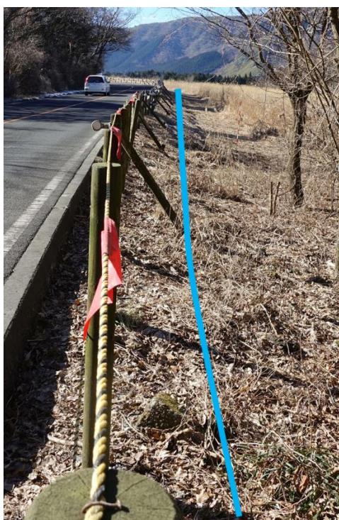
写真Ⅲ－4 歩道設置予定区間における未設置地点
