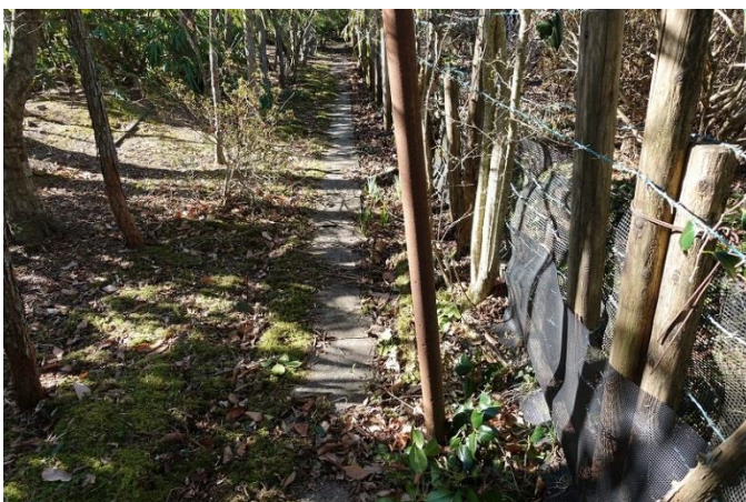
9. 湿生花園境界 電柱は内側になるように柵を設置する。
