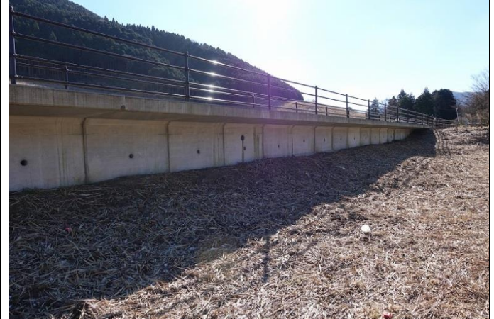
20. 天然記念物のコンクリート擁壁 柵設置の方法について検討が必要な場所。
