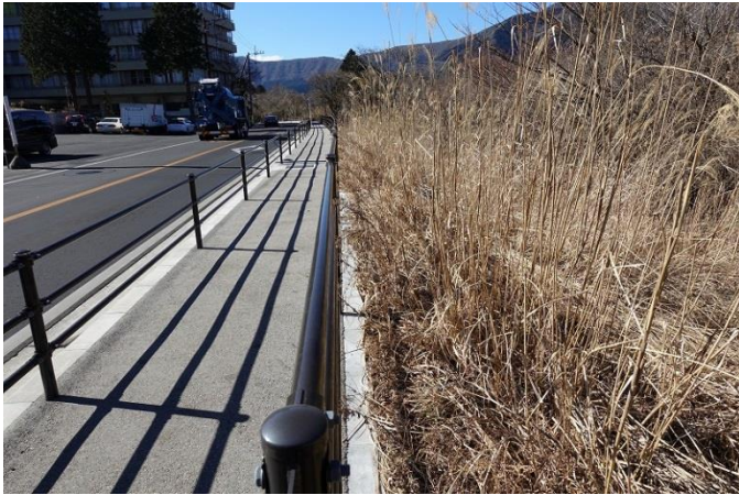
17. 新設された歩道 歩道に沿って柵を設置する。
