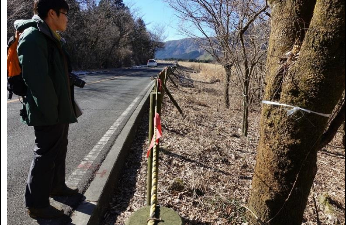
18. 歩道設置工事中の地点
