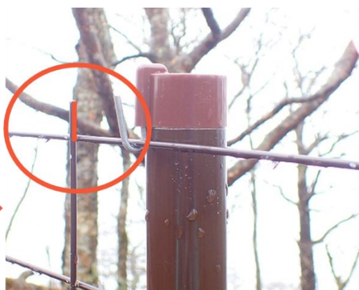
写真Ⅲ－３ 頂部の飛び出しが大きいワイヤメッシュ柵（左）と頂部の飛び出しを小さくしたワイヤメッシュ柵（右）
