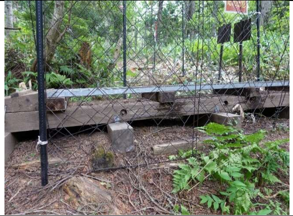
尾瀬沼の登山道に設置されたグレーチング (シカの足が入るように浮かせてある)
