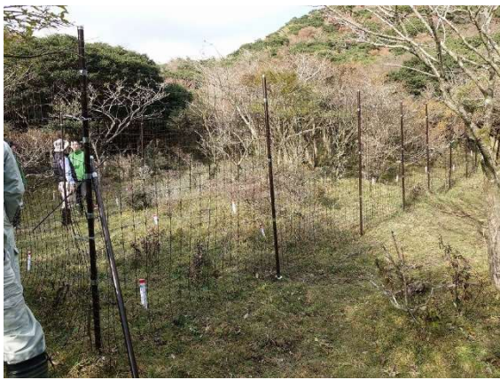
完成した植生保護柵
