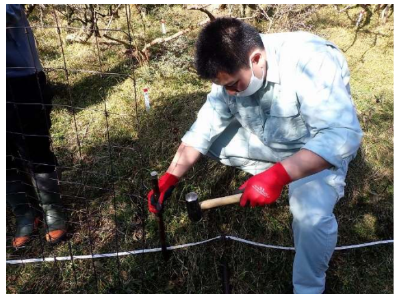
設置（支柱杭の打設）
