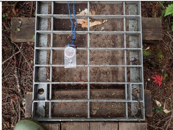
尾瀬沼の登山道に設置されたグレーチング (シカの足が入るように枠が大きい)
