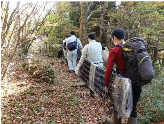
柵部材の運搬
