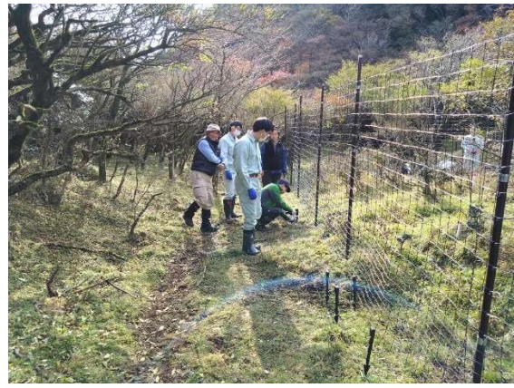
設置（アンカー杭の打設）
