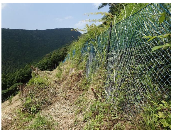
図 5-2-1 日常の見回りに該当する例 絡まったツルの除去
