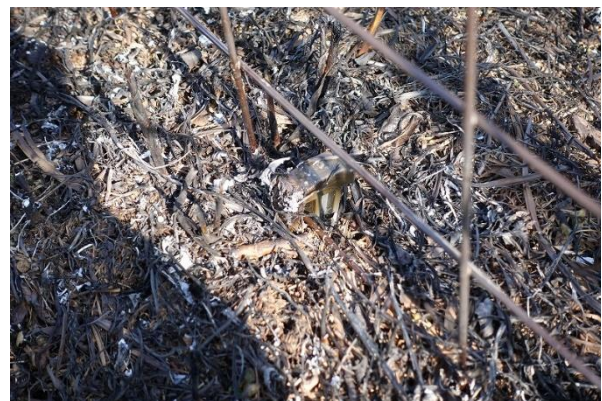
写真 3-2-2-8 アンカー杭も頭が溶ける
