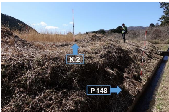
写真 3-1-1-11 K 2 と水路の間には段差がある
