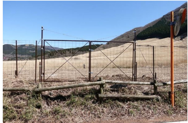
写真 3-2-1-2 本年度設置された扉 (2020年3月11日)
