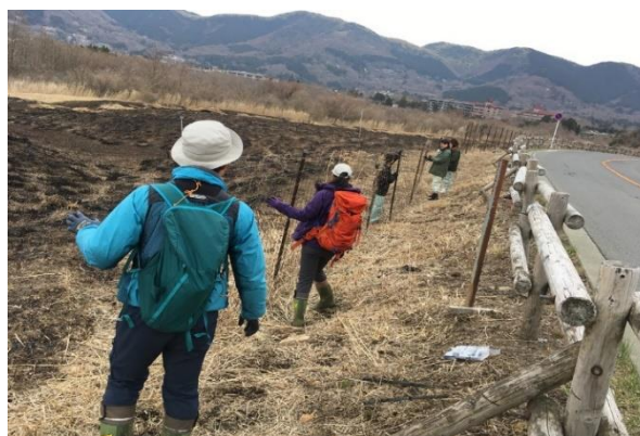
写真 3-2-2-12 パネルの再設置作業
