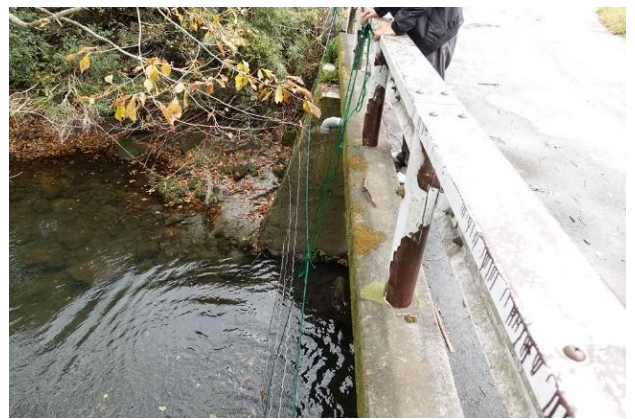
写真 2-2-2-20 紐を引くと下部の鎖とネットが引き上げられて出水に備えられる。紐を放すと鎖の重さでネットが落ち、設置状態になる。
