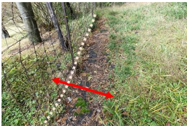
写真 2-2-2-11 スカート部分に設置された防草シート
