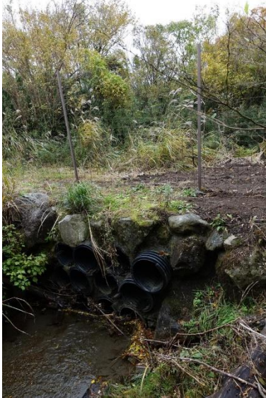
写真 2-2-2-17 小さい沢は管を埋めて台地を整形する。
