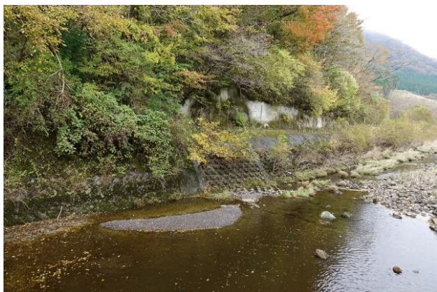
写真 2-2-2-13 管理が難しい急傾斜地も、斜面を削って作業道を確保した後に法面を固定し柵を設置。
