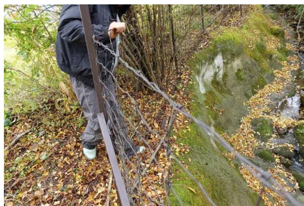
写真 2-2-2-16 既存の障壁がある所は高さを150cmと低くしている。
