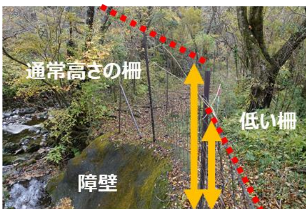
写真 2-2-2-15 既存の障壁がある所（手前）は柵の高さを低くしてコストを抑える。
