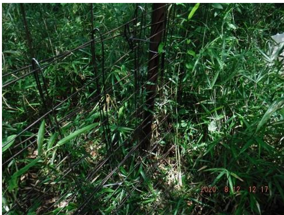
写真 3-2-2-1 柵補修後の様子（左上：補修場所 1 右上：補修場所 2 下：補修場所 4）
