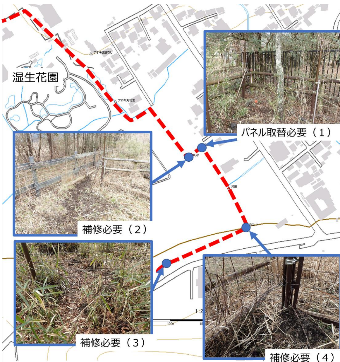
図3-2-2-1 植生保護柵の補修箇所
