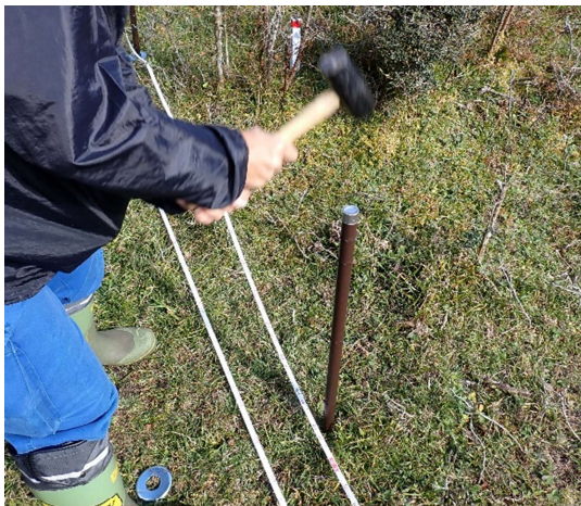
写真 5-1-1 支柱芯を打設する。
