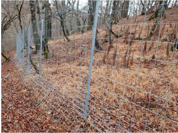
写真 2-1 金属ロールと金属支柱の柵
