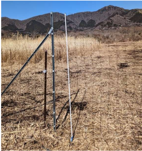
写真 4-1 高さを高くして設置された補修柵
