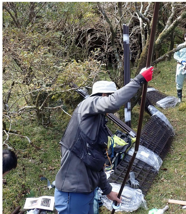
写真 5-1-2 支柱芯に支柱を被せる。
