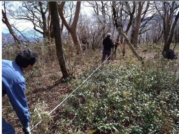
柵の設置位置の再確認
