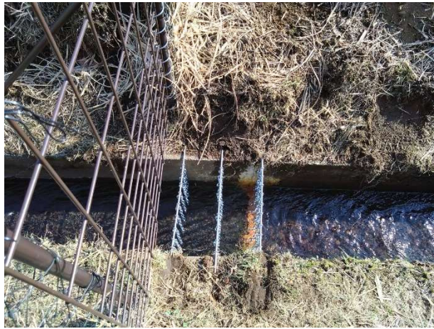
写真 4-4 水路との交点における改修工事（続き）
