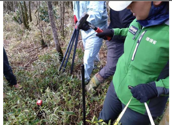
2m間隔になるように支柱の芯を打ち込む
