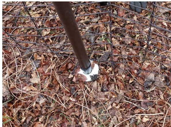
写真 5-1-4 ワッシャーの設置状況
