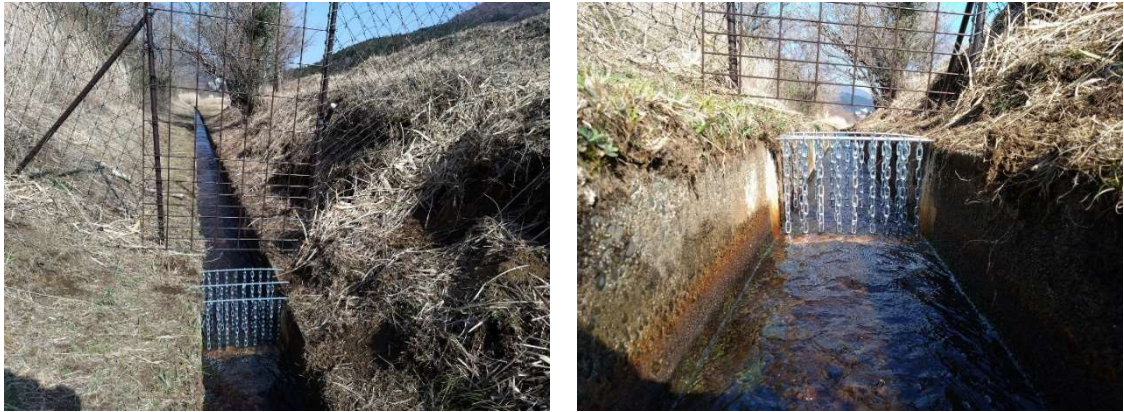
写真 4-3 水路との交点における改修工事
