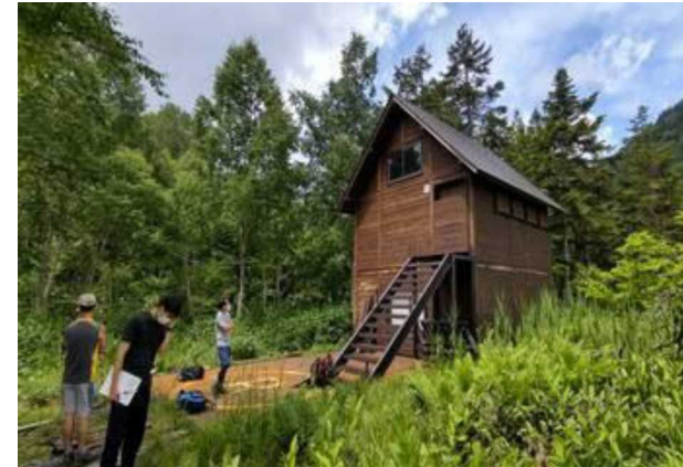
トイレ外観（ヘリポート）
