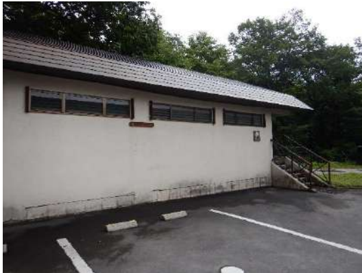
大清水のトイレ(外観)
