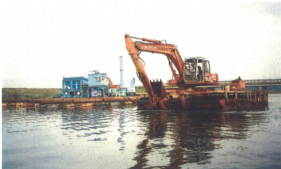
掘削機の事例写真
