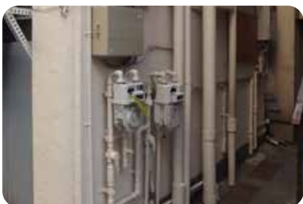
配管の色を壁の色と同系の色にすると目立ちにくい
