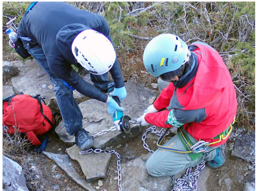
写真 3 2 : ディスクグラインダーでクサリを切断している様子
