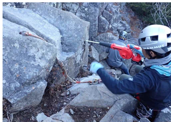
写真8：ブロワーで孔内を乾燥
