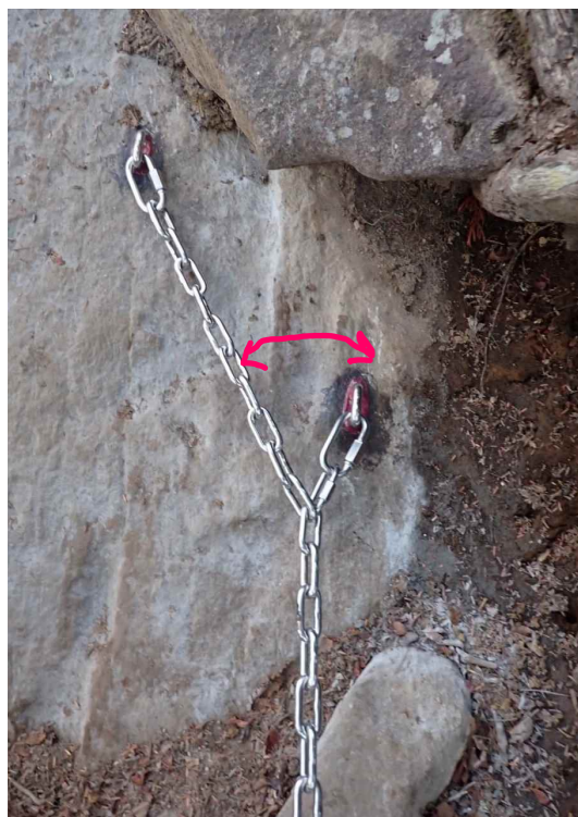
写真 2：分散荷重の施工例
