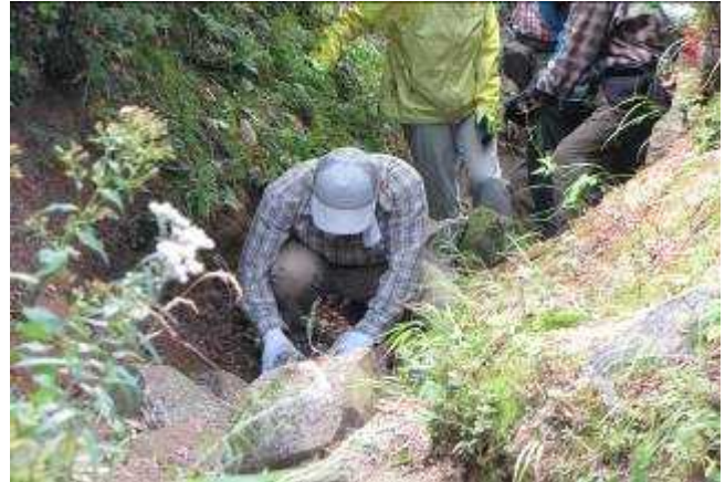
【石ダムを作っているところ】
