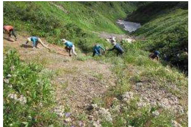
【急斜面に貼りつき手渡しで土砂を運ぶ】
