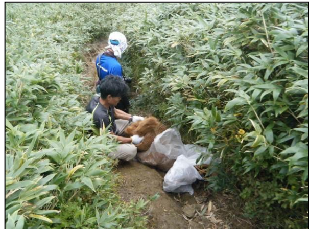
ヤシ繊維と土嚢袋による土留工設置
