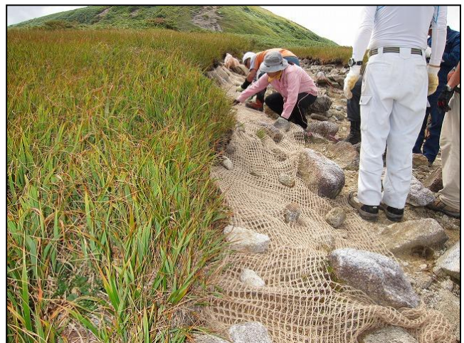
麻製緑化ネット敷設
