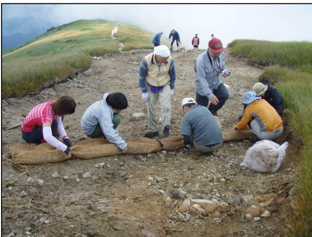
ヤシ製緑化ネットによる土留工
