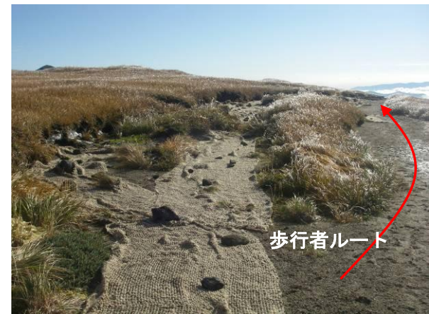
敷設後の様子②
