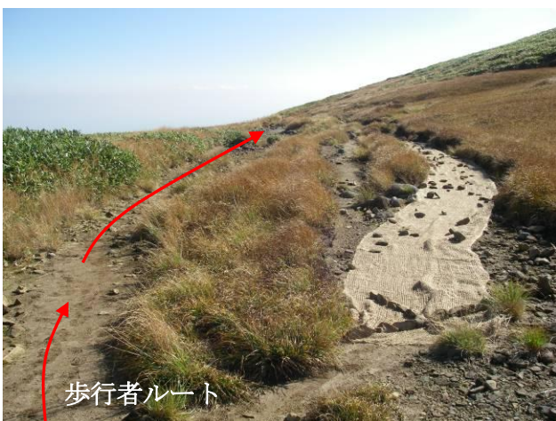
施工箇所② 複線箇所北側入口に緑化ネットを敷設
