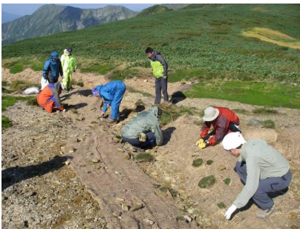
緑化ネットを敷設
