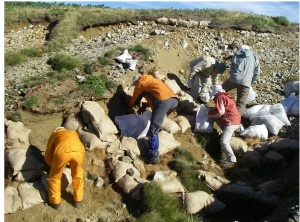
防風目的の土嚢袋を設置
