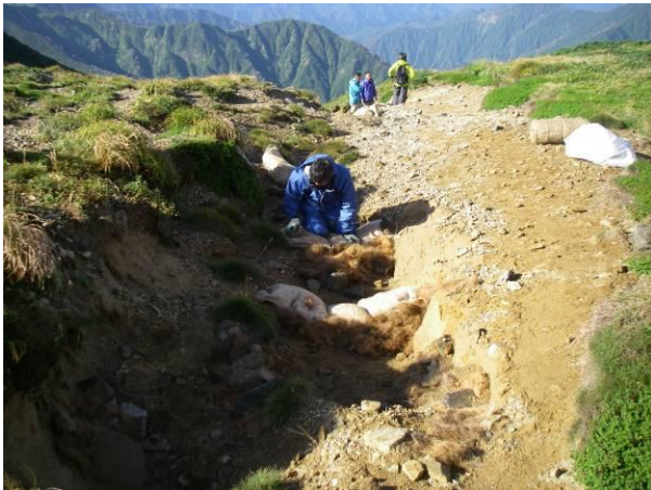
ガリー侵食部に土留工を設置
