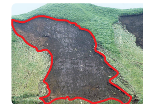
1990年豪雨による表層の崩落
