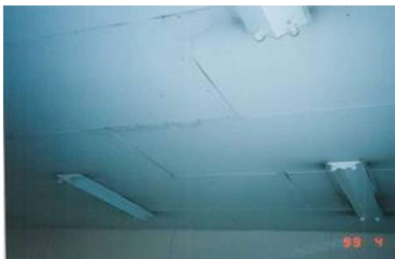
天井のスレート板
