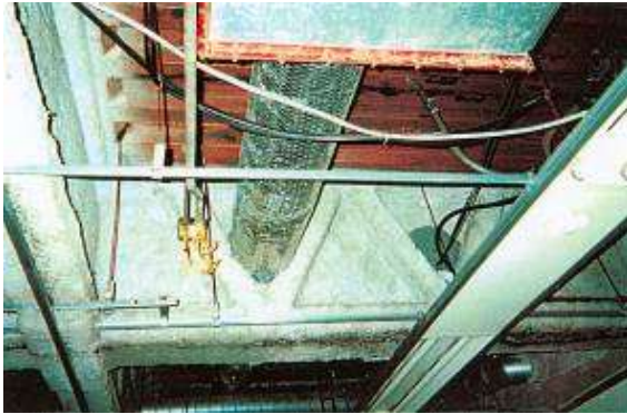
鉄骨造の梁・柱の耐火被覆
