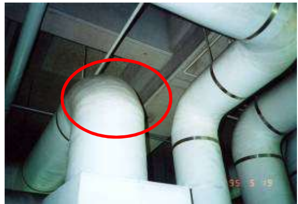
保温材（配管等）
