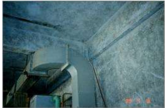
機械室の壁・天井の断熱
