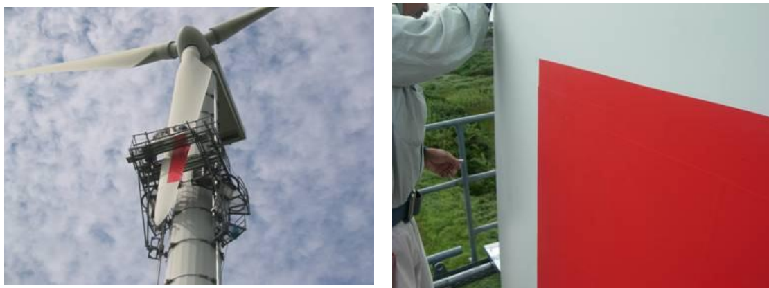
図 3-42 彩色作業実施状況(五島岐宿風力発電所)
