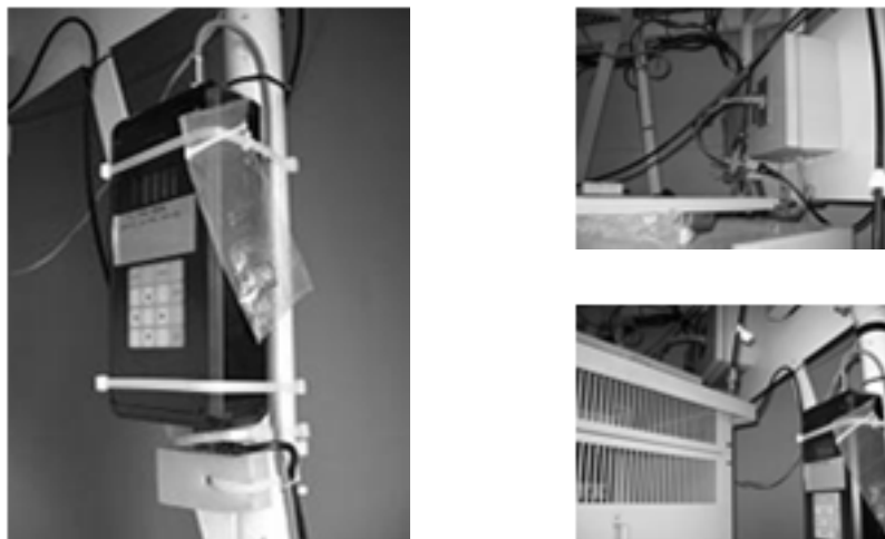
図 3-1- 56 本体ロガー設置状況
