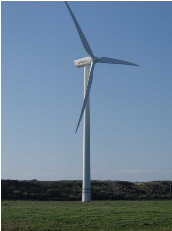
作業終了後の状況（遠景）
