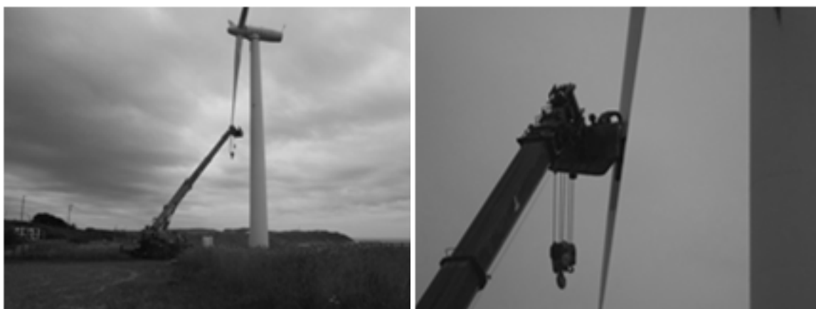
作業風景（遠景）
