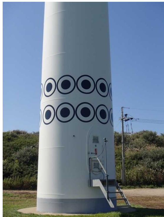
作業終了後の状況（近景）
