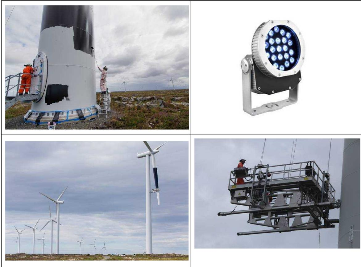
図 3-4-6 Jannicke Nilsen 氏の記事に掲載された塗装作業(上左)と UV 照明 (上右)、ブレードを塗装した風車 (下左) と塗装作業 (下右) 上段 : <http://www.tu.no/kraft/2014/02/25/kan-uv-lys-brukes-som-usynlig-fuglegjerde-rundt-vindparker> より転載、下段 : [http://www.tu.no/kraft/2013/09/18/prisen-for-a-male-atte-vindturbiner-750.000-kroner#cxrecs\\_s](http://www.tu.no/kraft/2013/09/18/prisen-for-a-male-atte-vindturbiner-750.000-kroner#cxrecs_s) より転載
