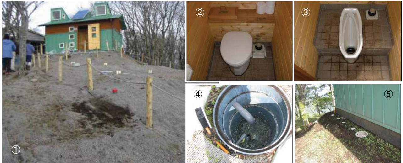
①トイレ全景、手前が土壌処理槽、②足踏みポンプ式洋式便器、③足踏みポンプ式和式便器 ④地下貯水槽点検口、⑤建物横に埋設してある接触消化槽のマンホール
