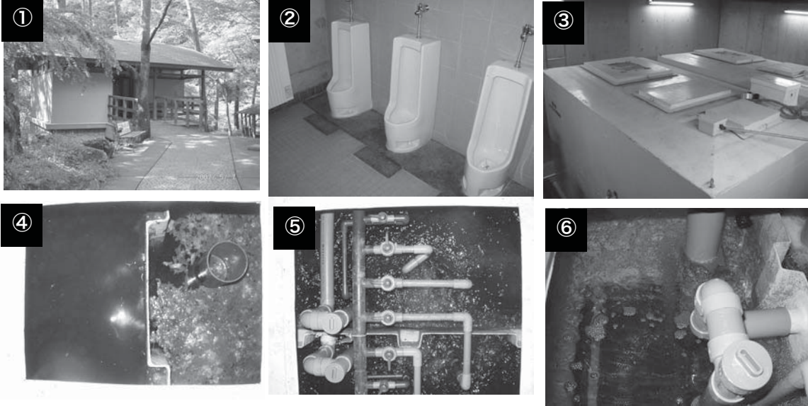
①トイレ外観 ②トイレ室内 ③処理装置外観 ④沈殿分離室 ⑤第1接触ばっ気室 ⑥オゾン接触室
