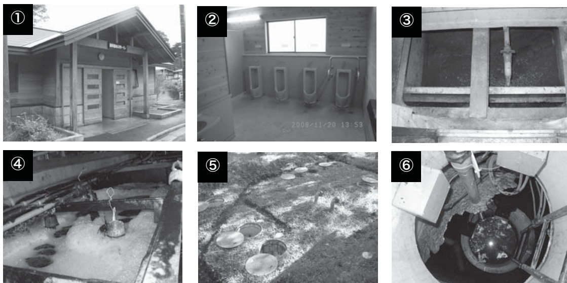
①正面 ②トイレ室内 ③受入槽 ④流動接触槽 ⑤高度処理ユニット・汚泥処理ユニット上部 ⑥集水槽
