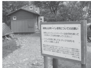
(鍋割山公衆トイレ)
