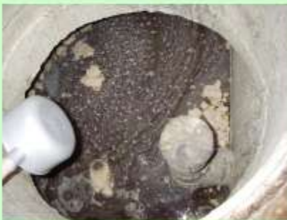
良好な状態であり、嫌気性菌の皮膜が被覆している
