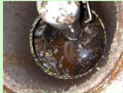
便槽内に異物の投入があり、嫌気性菌の皮膜の発達が阻害されている
