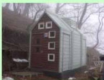
(樽洞丸公衆トイレ)
