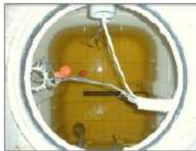
図7 貯水槽(運転変更後)
