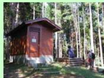
(南山園地公衆トイレ)
