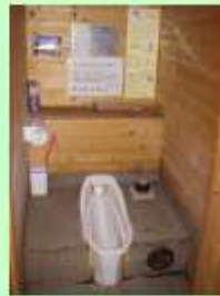
(樽洞丸公衆トイレ)
