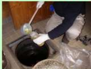
（鍋割山 洗浄水タンク）
