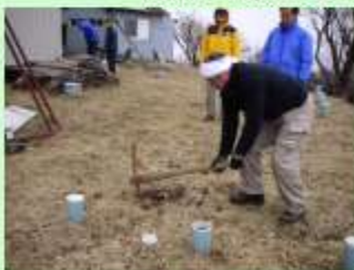
（塔ノ岳 土壌処理槽）
