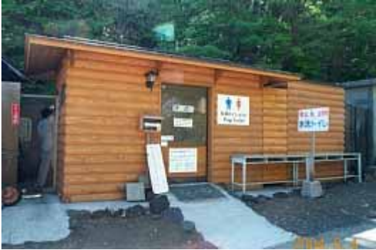
東富士山荘トイレ外観
