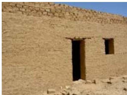
写真 6 . 建設中の裁縫グループアトリエ
