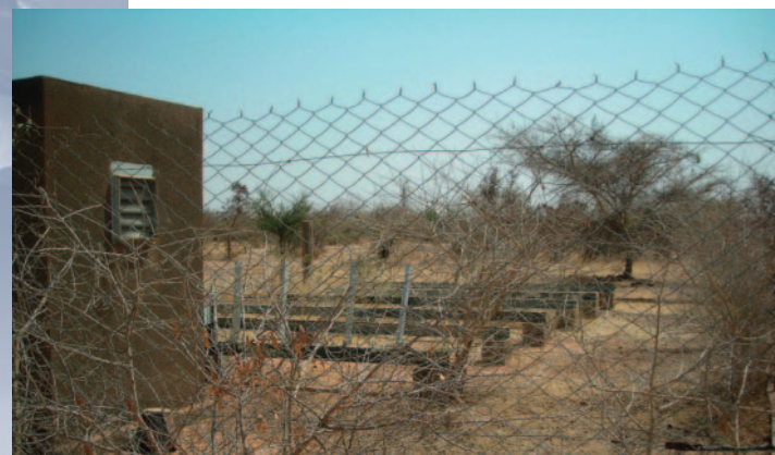
Emplacement des panneaux solaires dérobés
