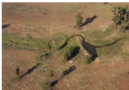
写真2. コーアル湖集水域のクリークを氾濫原にリンクさせる作業が進行している.
