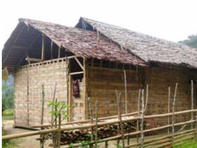
写真 11 サゴヤシの葉で葺いた屋根
