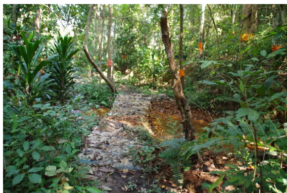
写真 14 チェックダム
