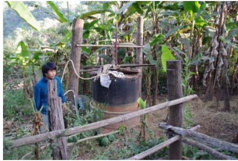
写真5 バイオガス収集装置
