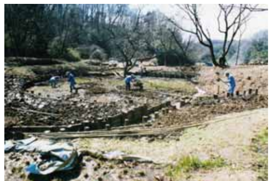
写真 溜池の復元作業の様子
